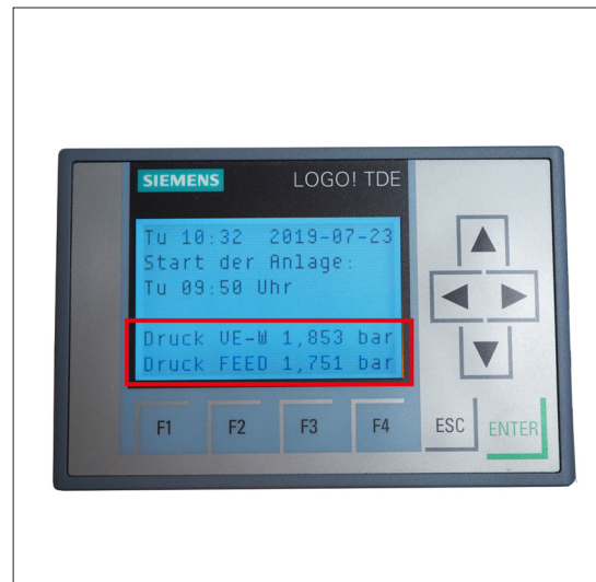
Abbildung 6: Display am Schaltschrank
